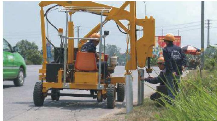
Hình ảnh máy đóng cọc lan can
